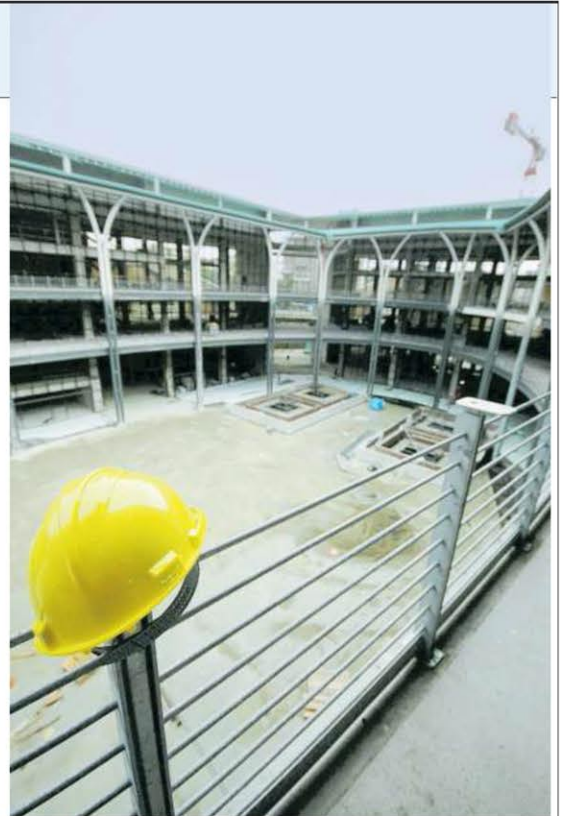
▲ Lavori al palo Secondo i costruttori edili del Piemonte, solo il 15% dei cantieri prosegue per motivi urgenti
