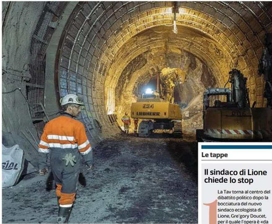
Nel tunnel Un operaio al lavoro nel cantiere della Tav
