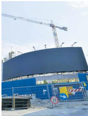
▲ Cantieri fermi La denuncia dei costruttori
