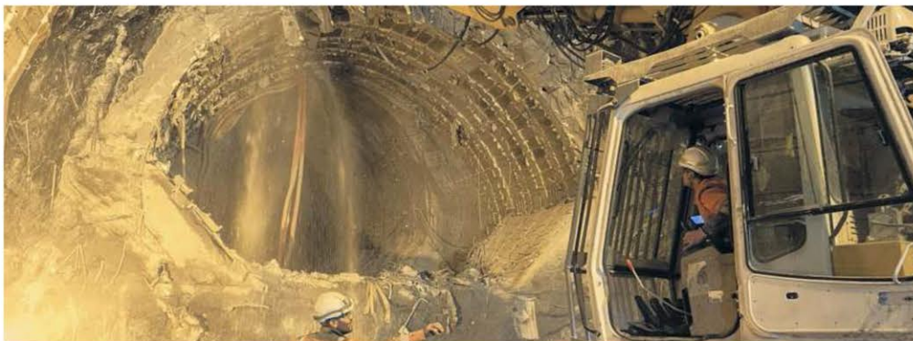
Il cantiere della Torino-Lione, a Chiomonte
