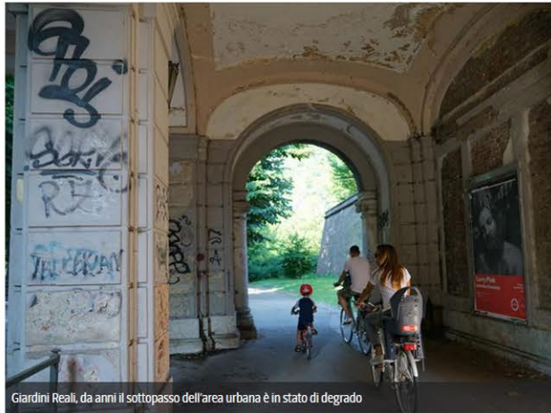
Giardini Reali, da anni il sottopasso dell'area urbana è in stato di degrado
