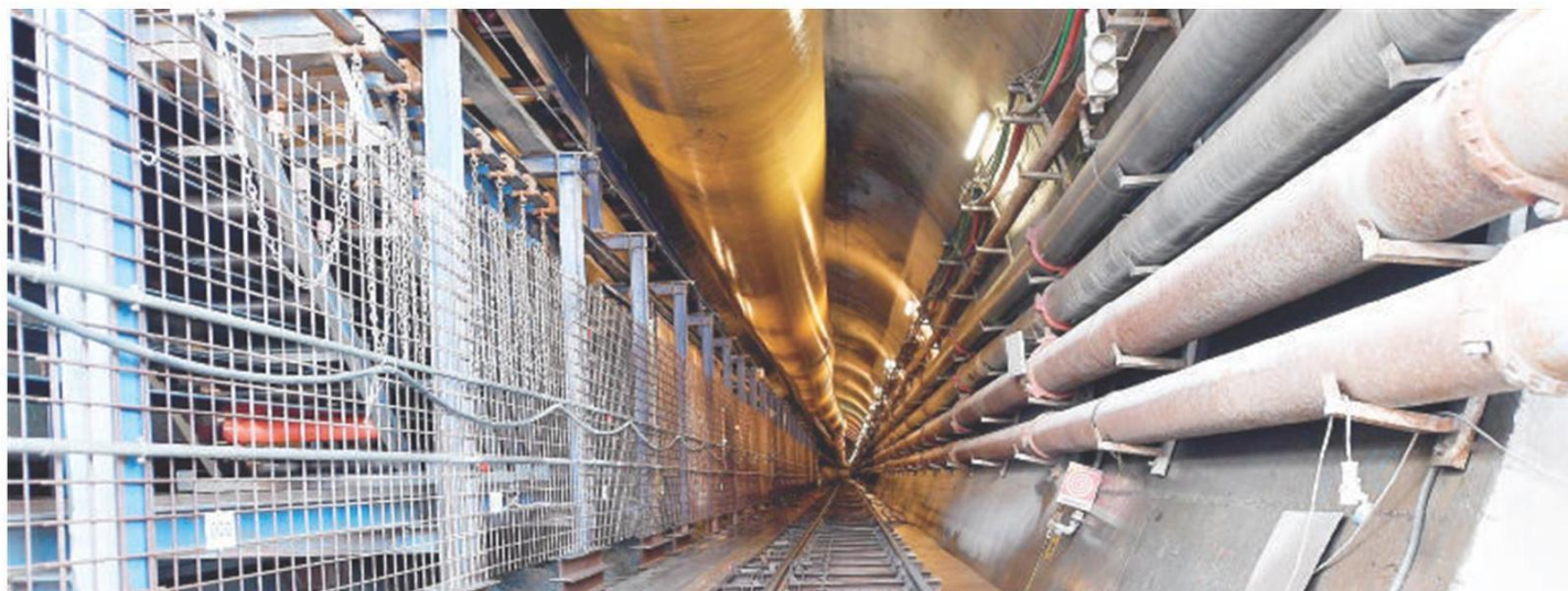
Il cantiere della Torino-Lione a Chiomonte: mentre il nuovo Governo si riserva di valutare costi e benefici dell'opera si lavora sul versante italiano e, ancora più speditamente, su quello francese
